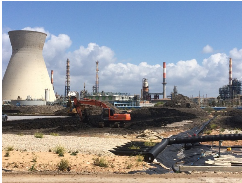
תמונה 22: ערימות הטיפול הביולוגי בבוצה. בקדמת התמונה צנרת האוורור במידה וישמשו בשיטת טיפול של ערימות גדולות (צילום: אלון בן מאיר)
