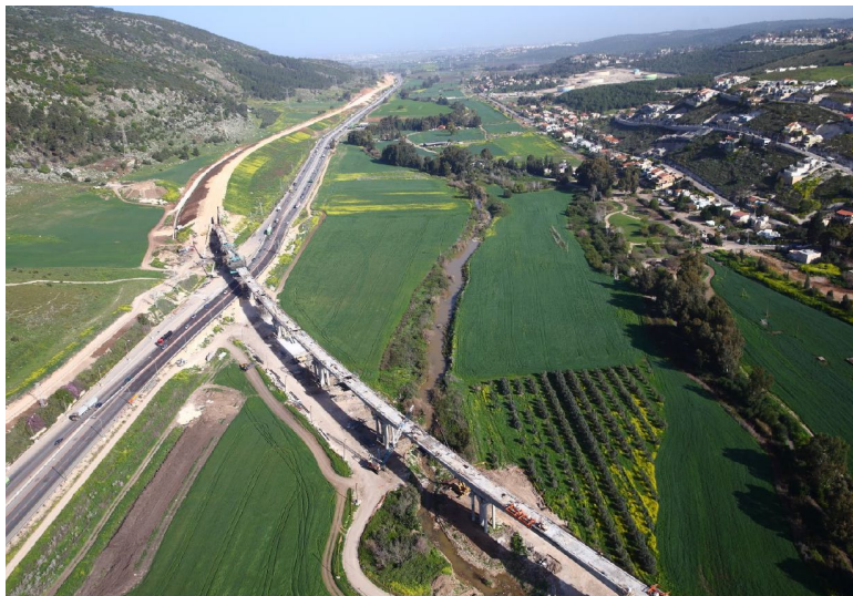
תמונה 13: גשר רכבת העמק מעל נחל קישון, ניצבים 6-9 בעת ביצוע העבודה (מקור: שפיר, הנדסה ימית ואזרחית בע"מ)
