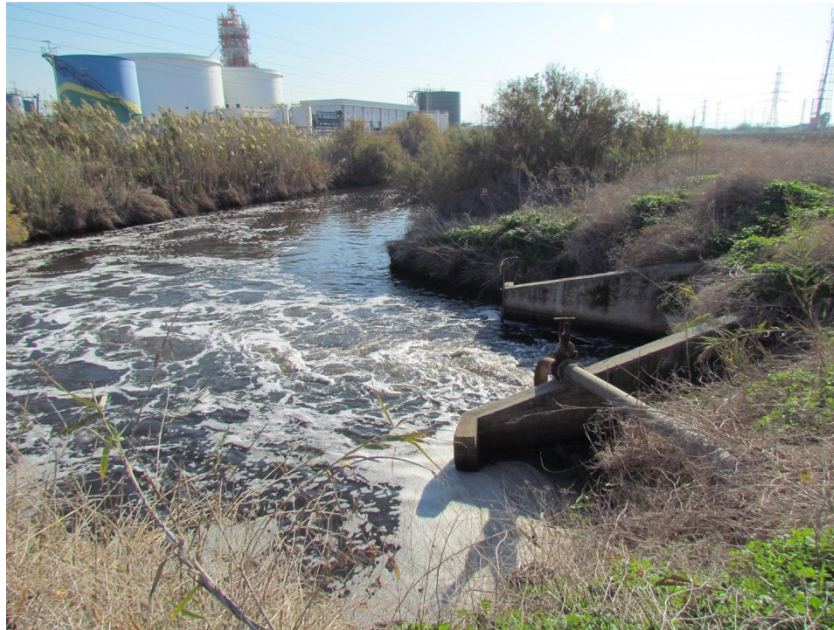
תמונה 8: אירוע הגלשת קולחי מט"ש חיפה כתוצאה מעבודות שידרוג קו תשלובת הקישון
