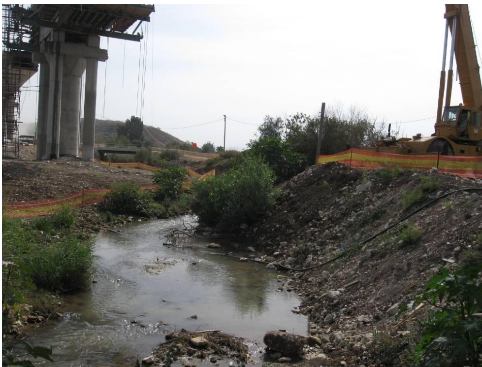
נספח 2. תחנת "מורד תל קשיש" - עבודות בנייה מסיביות להקמת גשר רכבת העמק במעלה אזור הדיגום. ניתן לראות את השינויים מורפולוגיים בתוואי הנחל, המתבטאים בהצרה של תוואי הזרימה, שינויים במבנה הגדות ועקירה של צמחיית גדות (צילום: אלדד אלרון).
