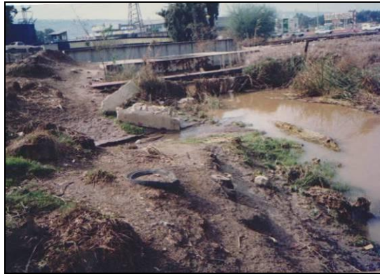
קומפלקס גשרי הפטרוכימיים, מצבור הפרעות חמורות לזרימה
