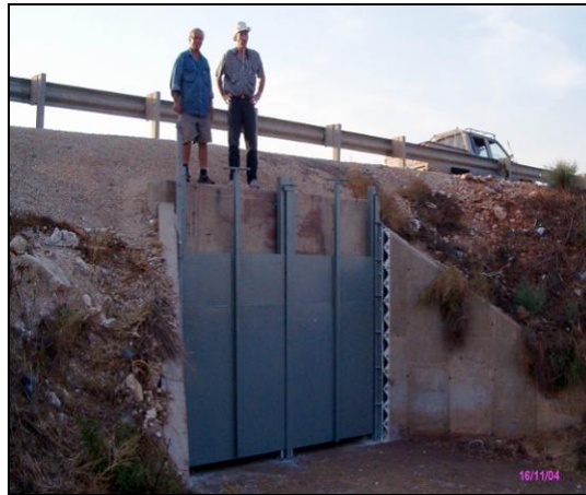
אזור המאגר, מעביר המים מתחת לכביש כולל סגר זמני.
