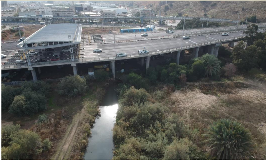
מבט לעבר הנחל העובר מתחת לכביש הכניסה למנהרות הכרמל
