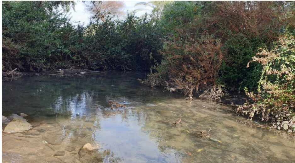
מבט לעבר הנחל העובר מתחת לכביש הכניסה למנהרות הכרמל
