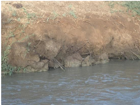
תמונה 4. קריסת קרקע בצד הגדה החשוף מצומח במקטע גשר אירי יגור, סתיו 2022
