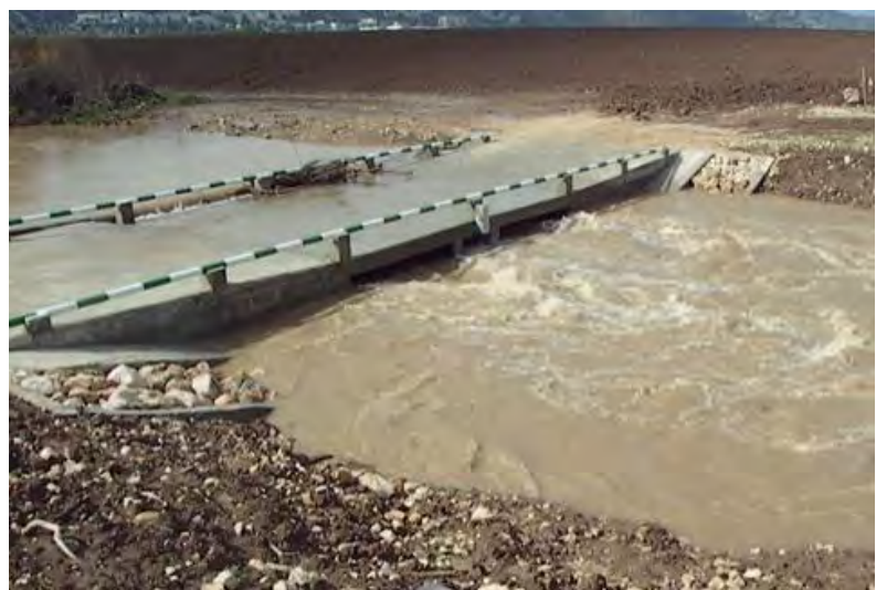
תמונה 3: תפקוד המעביר בעת שיטפון במהלך פברואר 2022. מי הנחל עוברים בשלושת תאי המעביר
