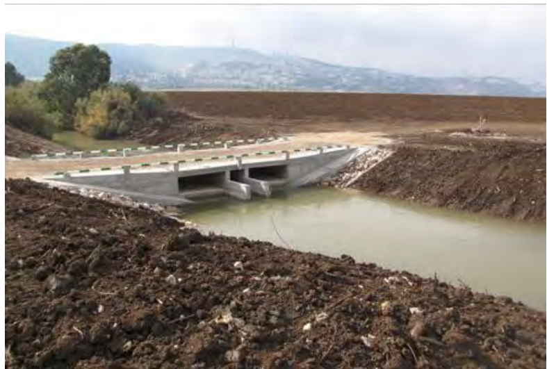
תמונה 2: המתקן לאחר השלמתו. התא המרכזי משמש למדידת ספיקת הבסיס ומליחות מי הנחל
