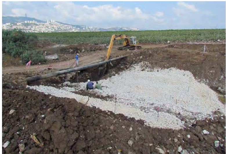
תמונה 1: תחילת ביצוע המתקן לאחר הטיית מי הנחל במעקף זמני
