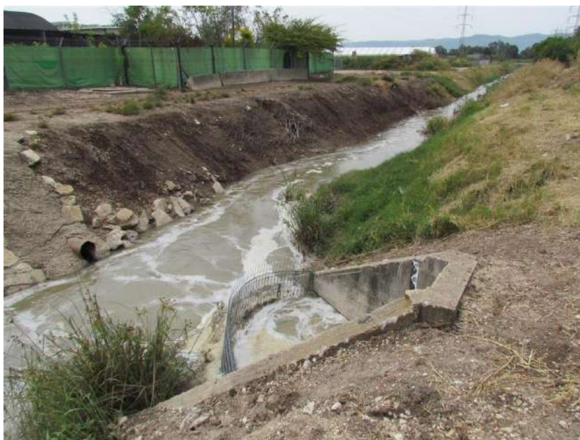
תמונה 3: גלישת הביוב לנחל גדורה בעקבות כשל בקו מאסף דרך עכו
