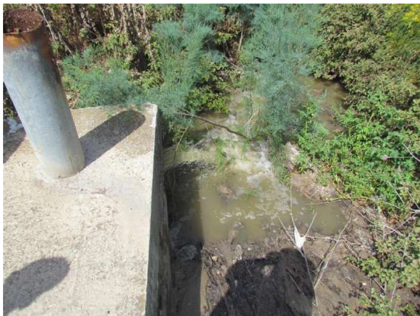
תמונה 4: גלישת הביוב מהשוחה על קו מאסף ראשי חיפה לנחל סעדיה
