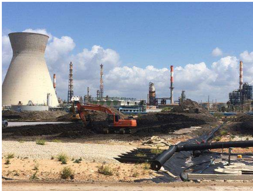
תמונה 14: ערימות הטיפול הביולוגי בבוצה. בקדמת התמונה צנרת האוורור במידה וישמשו בשיטת טיפול של ערימות גדולות (צילום: אלון בן מאיר)
